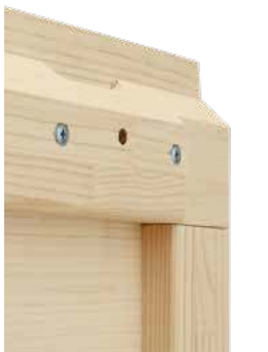
Verstärkung an den Lamellenenden
